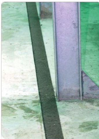
Figure 8 – Mise en place des bandes bitumeuses
