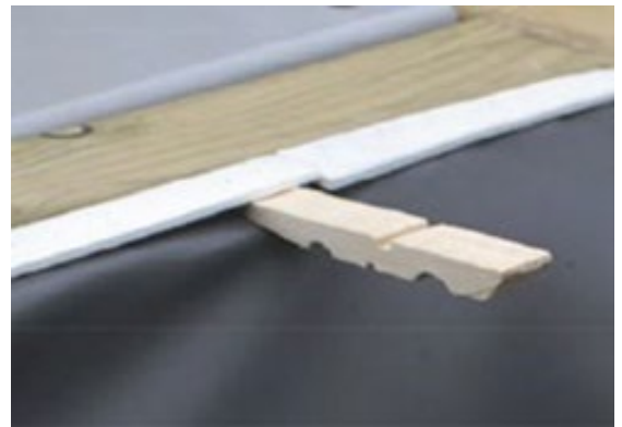
Figure 32 – Verrouillage du liner grâce à des demi épingles à linge
