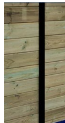
Figure 20 – Adhésif de protection
